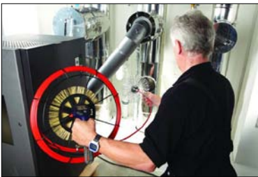
Abb. 5: Reinigung eines Edelstahlschornsteins
