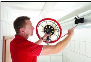
Abb. 6: Reinigung eines Lüftungsrohres
